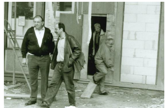
Bei der Baustellen-Besichtigung: (v.r.n.l.): Manfred Kahl, Frank Bodis, Michael Lechner (Bauhaus-Geschäftsführer), Herr Schmittl, Polier (Bauhaus).
