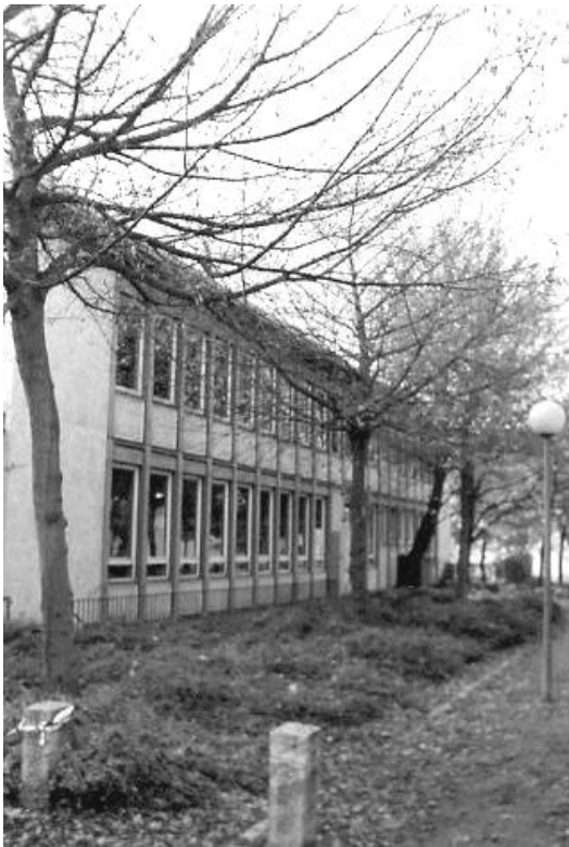
Das Nachbarschaftshaus vom Jägerhof aus. Nach dem Umbau wird es ein weiteres Stockwerk tragen...
