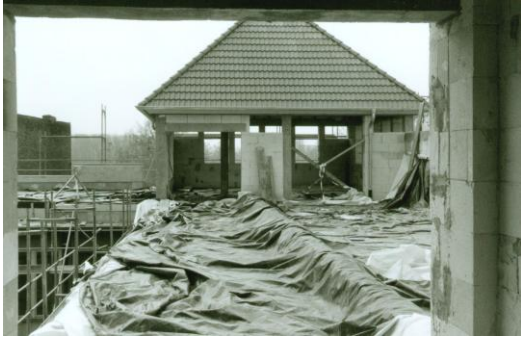
Provisorische Abdeckung der Freiflächen, die aber gegen eindringendes Wasser nicht wirklich Schutz bietet.
