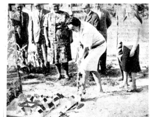
Beim ersten Spatenstich für das Biebricher Nachbarschaftshaus: Hildegard Lutsch und die beiden Mit-Initiatorinnen Marzot Fausi (links) und Dr. Hildegard Feick. Foto:Bot
