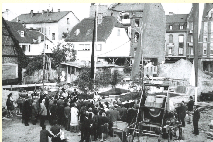
Grundsteinlegung für das Nachbarschaftshaus in Biebrich im Jahr 1964.
